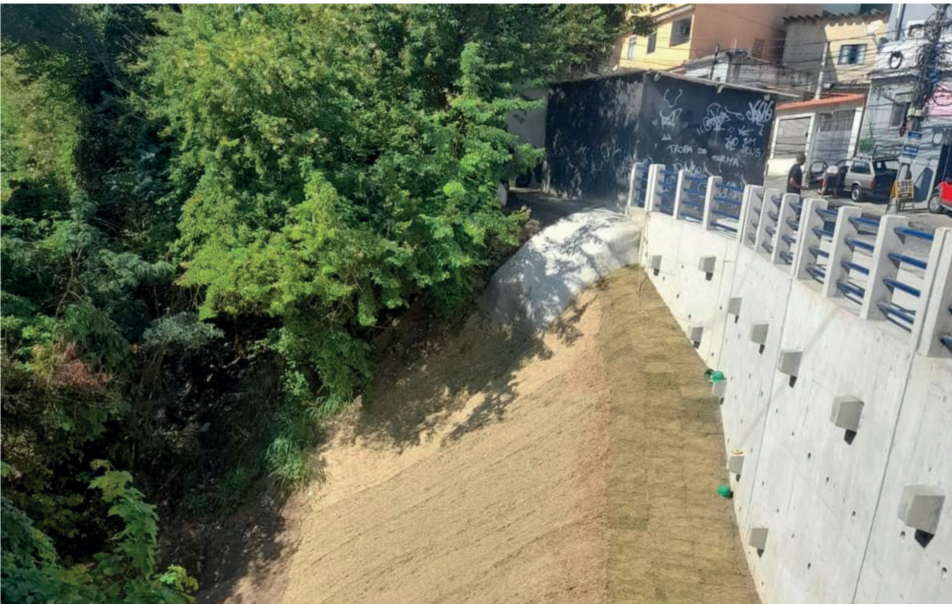
Uma nova estrutura de contenção foi erguida na Avenida das Américas. Foto: Divulgação/SMI
