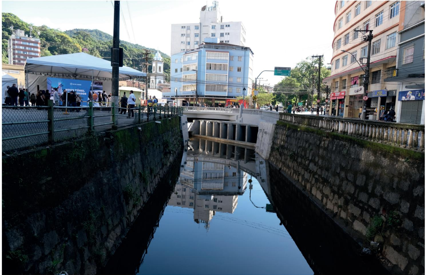
de 2,5 km de estrutura até o seu deságue, no Rio Piabanha. As obras executadas contemplaram a concretagem do fundo da galeria subterrânea, instalação de comportas na entrada do túnel — na altura da Rua Souza Franco, no Rio Palatino — além do jateamento de concreto nas paredes e teto, aplicação de resina anticorrosiva e manutenção
